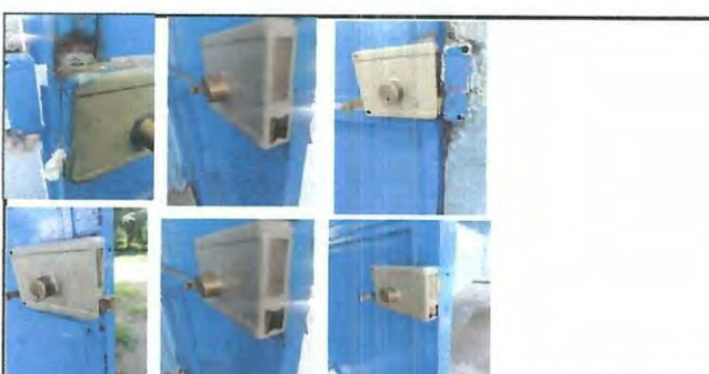
Foto 6: Fotos de algunas de las chapas que ya no sirven de aulas y oficinas y bodegas
