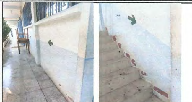
Foto1: Fotos del pasillo módulos 4 y 5.
